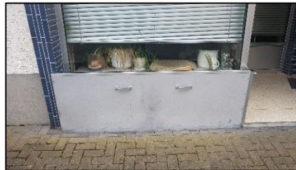
Abbildung 13: Beispiele von Objektschutzmaßnahmen (mobile Steckelemente, Dammbalkensysteme, Abdichtungen)
